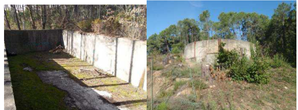
Sécurisation prévue dans le marché de travaux (propriétaire des terrains mairie)
